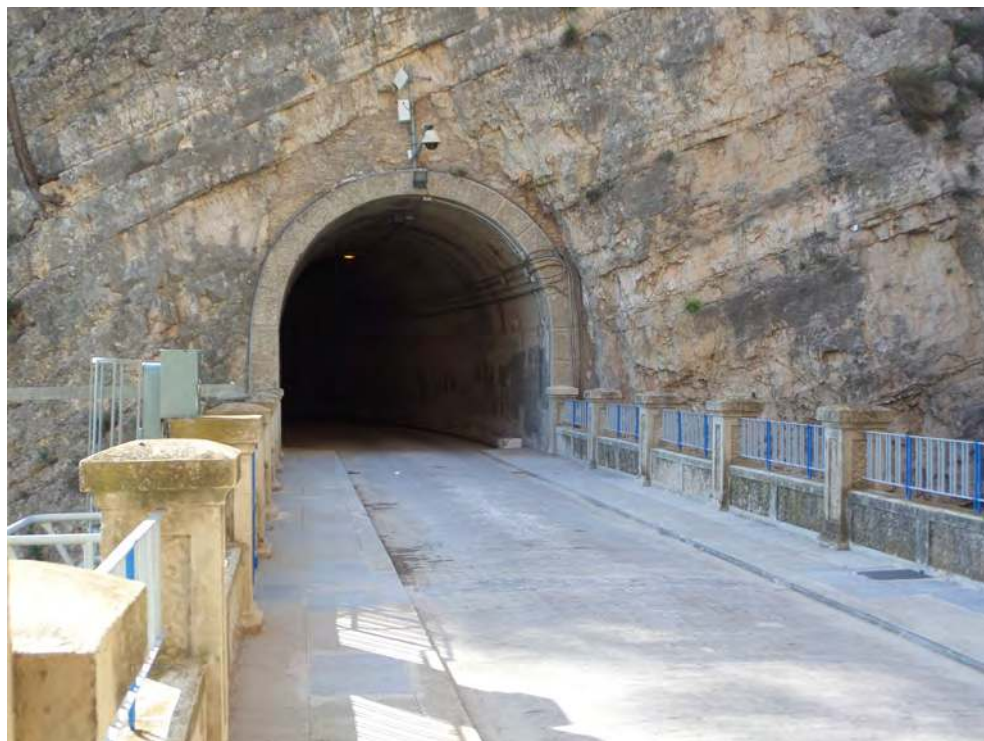
Túnel en el embalse de Camarillas (DC)
