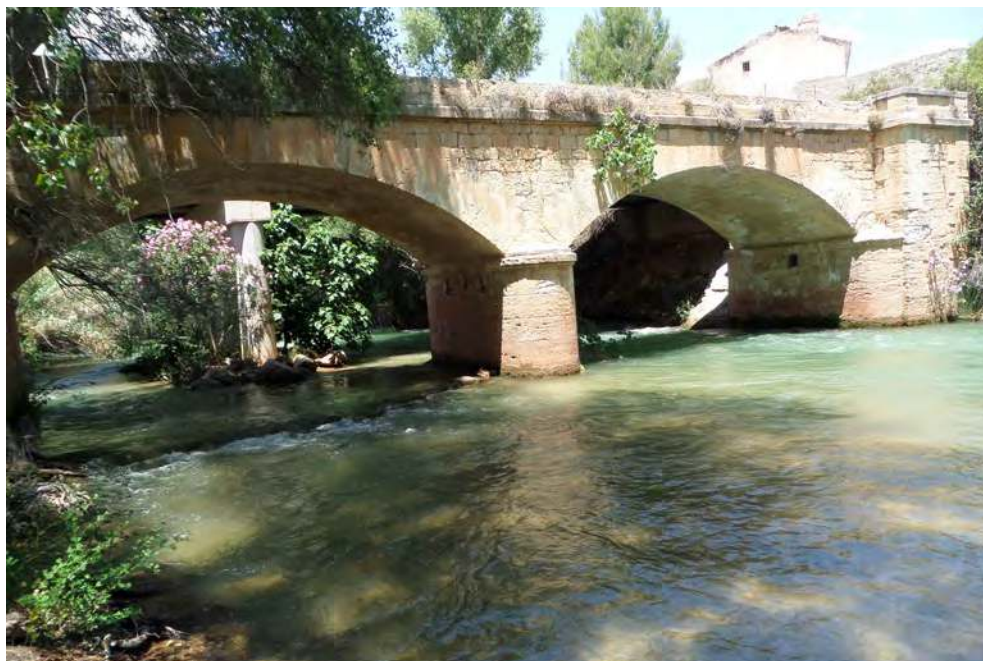
Puente romano sobre el río Mundo, en Isso, Hellín (DC)
