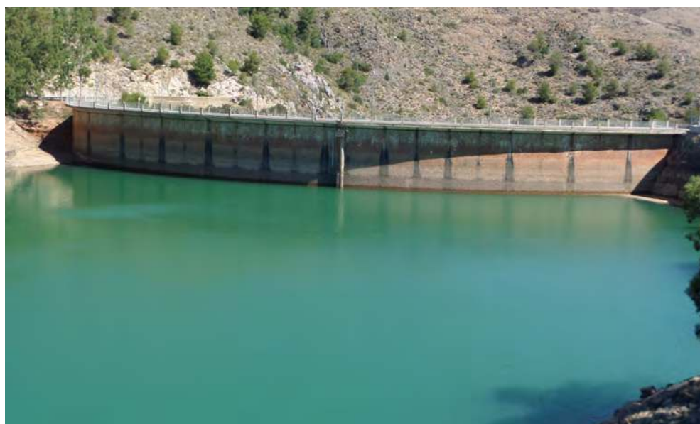
Presa del pantano de Talave (DC)
