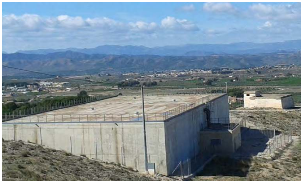
Depósito alto, junto a la antigua ermita Cruz de la Langosta, en el Calvario, cuya capacidad es de 5000 m 3 (foto facilitada por Aqualia)
