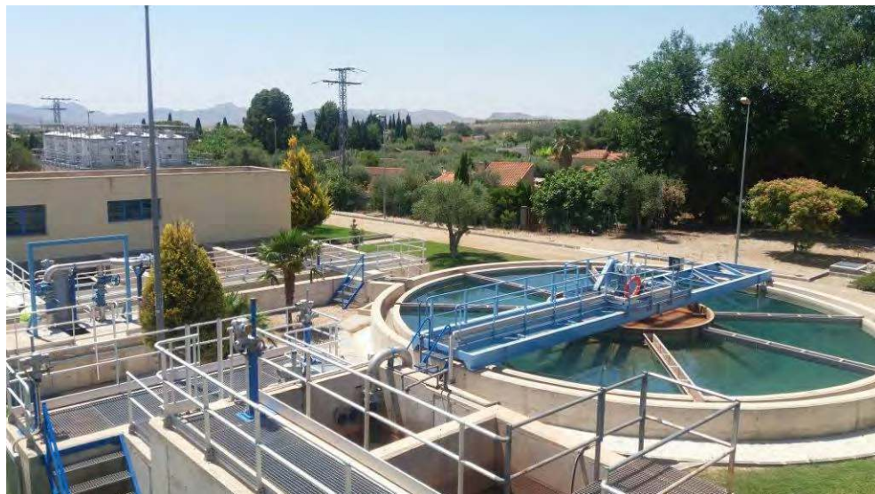
Nueva ETAP, en la Losilla (foto facilitada por Aqualia)
